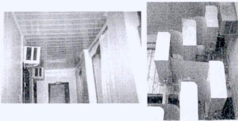
Hình 3: Không lắp dàn nóng ở nơi không thoáng gió và nên làm thông thoáng dàn nóng
